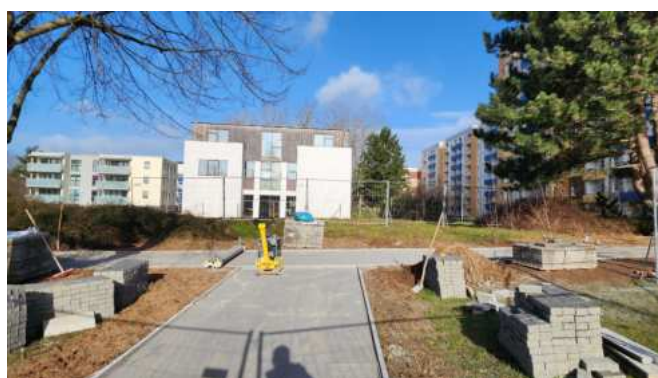
Baufortschritt im Februar 2024 FOTO DS STK
